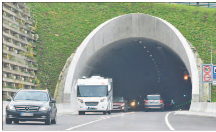
Das Nordportal des Reutlinger Scheibengipfeltunnels.
